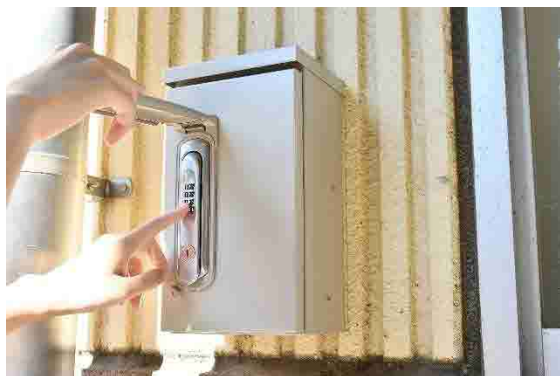
越谷市立中学校の体育館外壁に取り付けられているダイヤル BOX
