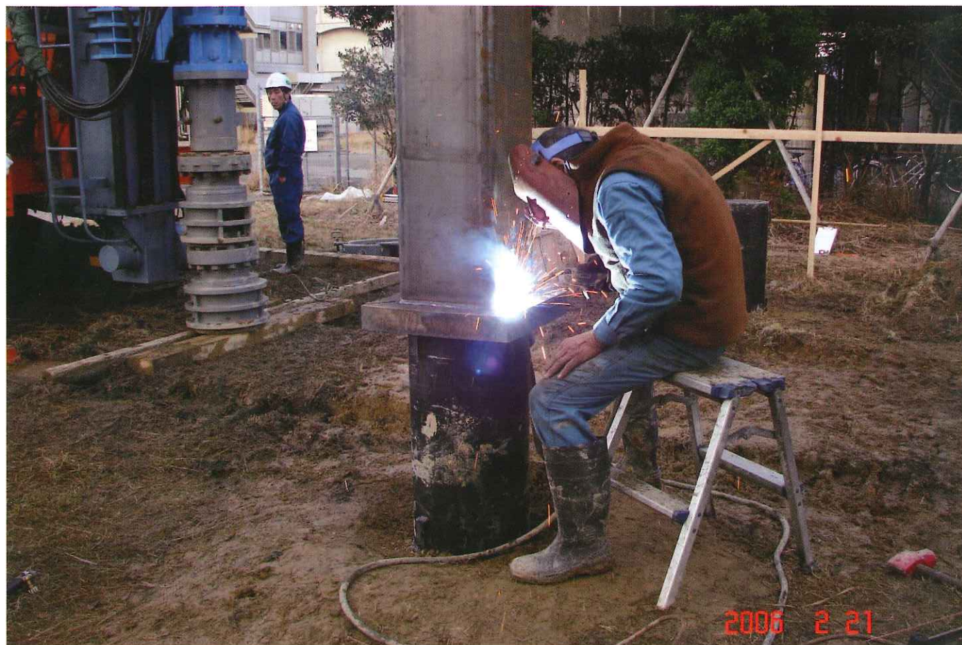
KK-ONE工法の杭・柱溶接施工状況（下向溶接実施）
