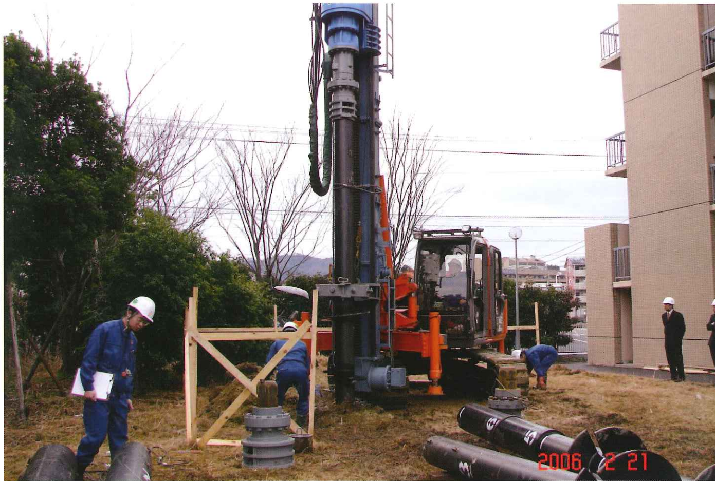
KK-ONE工法の杭打設状況
