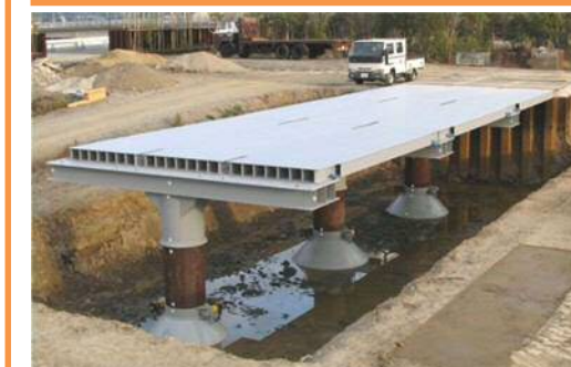
幅員 6.0mの作業構台 全景
